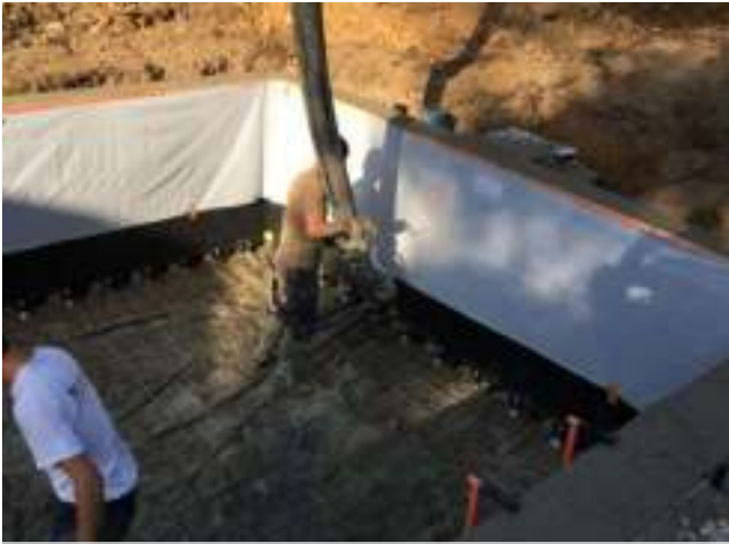
4. CONCRETE POURING
